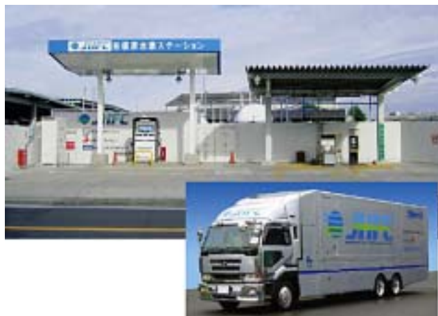
<写真上>相模原水素ステーション <写真下>移動式水素製造設備
