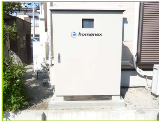
＜実証機 千葉県内＞ （12kWhリチウム電池）
