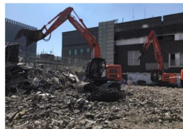
日本社ビル解体工事現場
