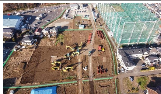
重機稼働現場
