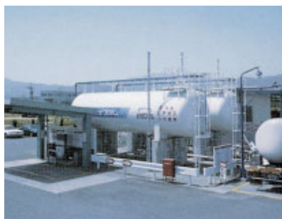
LPガス充填所
