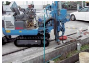
SS内ボーリング調査
