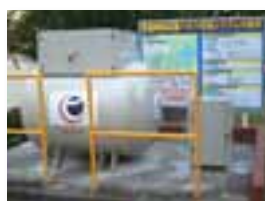
500kgバルク貯槽と分岐ユニット
