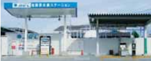
相模原水素ステーション(アルカリ水電解水素供給設備)
