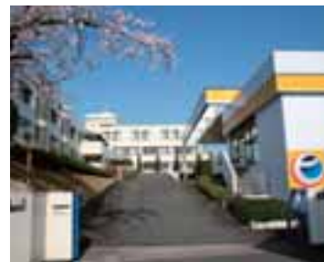
伊藤忠エネクス 中央研修所施設概要 敷地面積6,764㎡ 建築面積1,734㎡ 建物延床面積3,900㎡ 収容人数100名。 研修棟と宿泊棟で構成され、講堂、教室、自習室、和室(40畳)、模擬SS、SSガス共用の実習室などの他、快適なサウナ施設も完備。
