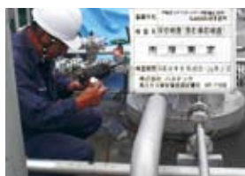
高圧ガス施設の肉厚測定
