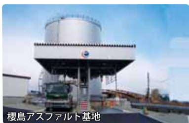
櫻島アスファルト基地
