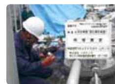
高圧ガス施設の肉厚測定
