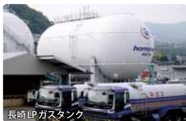
長崎LPガスタンク
