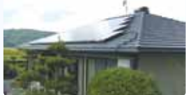
太陽光発電の施工例
