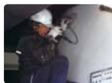
ファイバースコープによる内部目視検査
