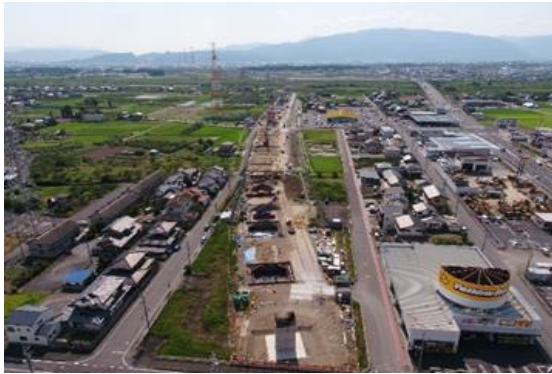
工事作業所(全景)
