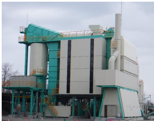
アスファルトプラント全景
