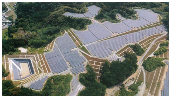
事例2) 南向き固定の両面発電
