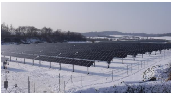
事例1) 発電量増加の為に東西追尾の両面発電
