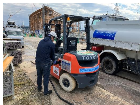
大阪・関西万博の工事で使用するフォークリフト
