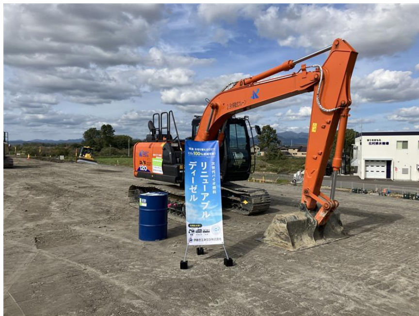
写真1:RD 使用機器(日立建機社製 0.45 m 3 バックホウ)
