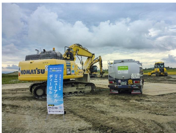
札幌市近郊の工事現場
