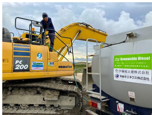
建設機械に RD を給油する様子
