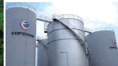
長崎ガス石油基地
