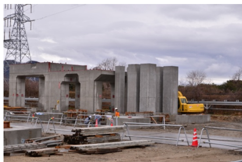
防府市の石炭火力発電設備の増設 (36MW 建設中) 2015年3月末完工予定
