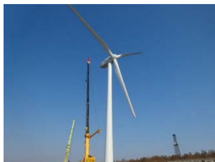
胎内市の風力発電設備 (20MW 建設中) 2014年8月末完工予定
