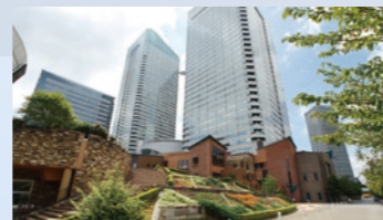
東京都市サービス(株)の本社がある晴海のオフィスビル
