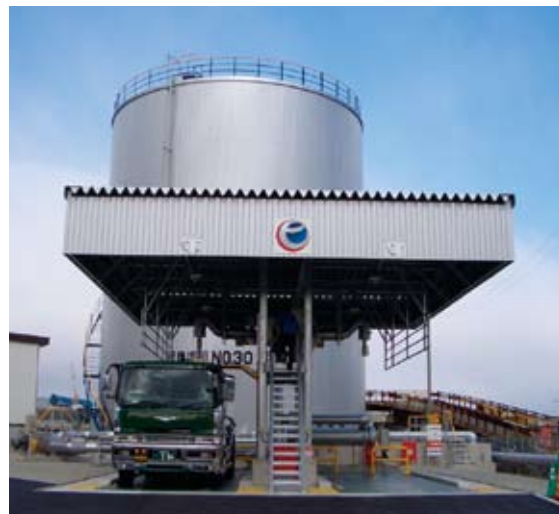
●櫻島埠頭アスファルトタンクの施設概要
