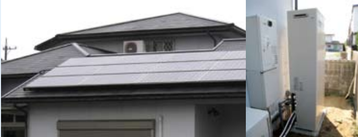
W発電設置例（三重県）
