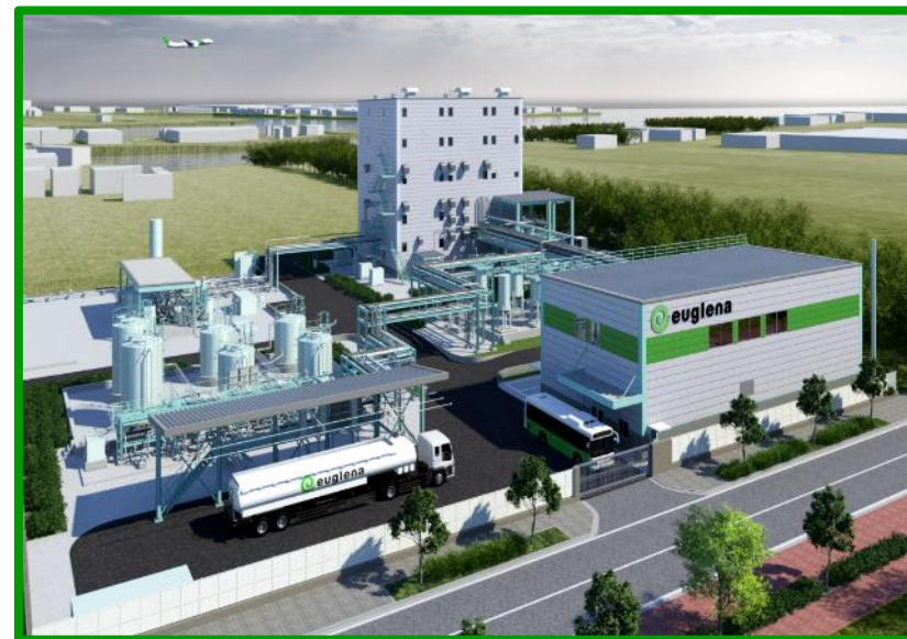
2018年10月31日 実証プラントの竣工
