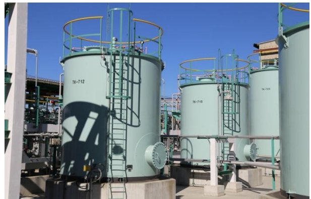
完成した実証プラント。バイオ燃料の製造設備(左)、貯蔵タンク(右)
