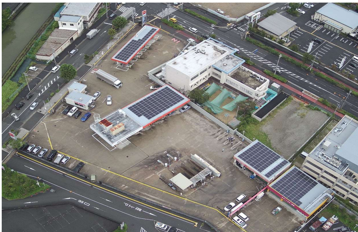
① CS 全景（空撮画像）
