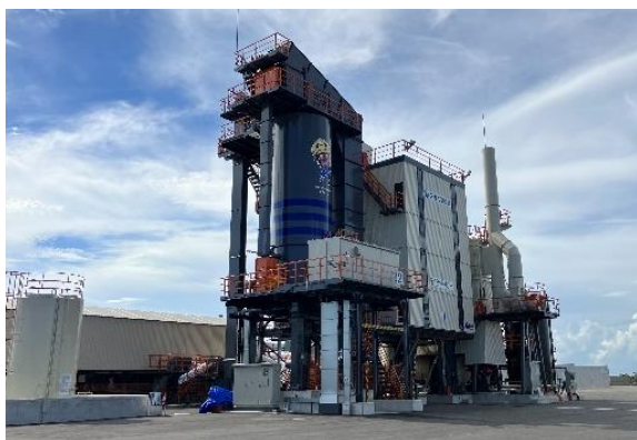
アスファルトプラント全景
